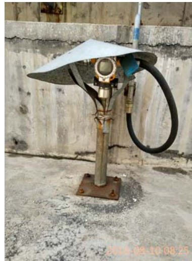
图 6-1b 水解酸化池硫化氢报警器
