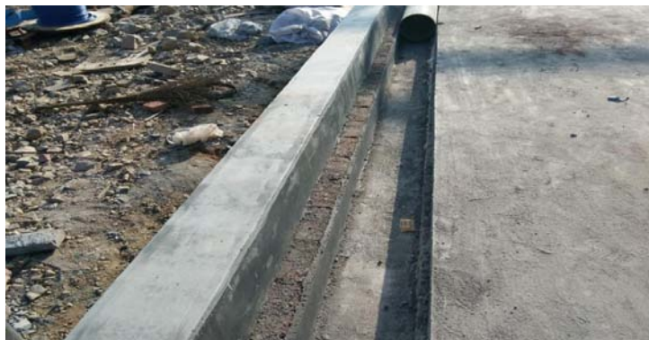
图 6-2a 生产装置区围堰及地沟
