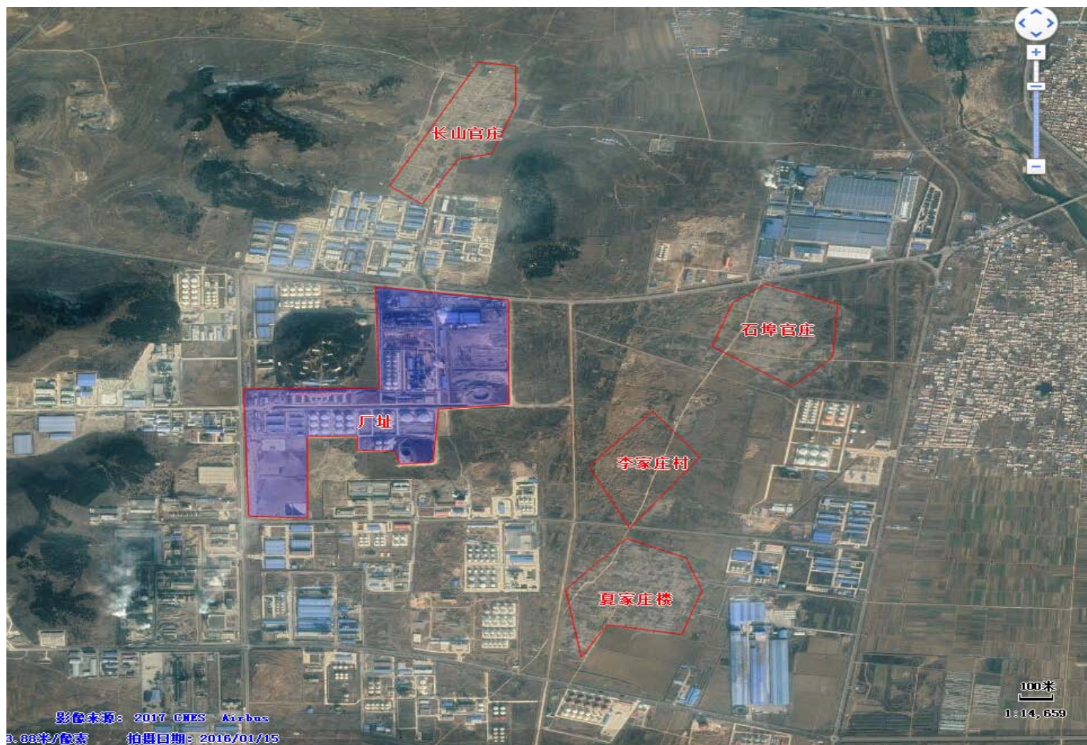
续图 2-3 项目周边居民聚集点拆除情况
