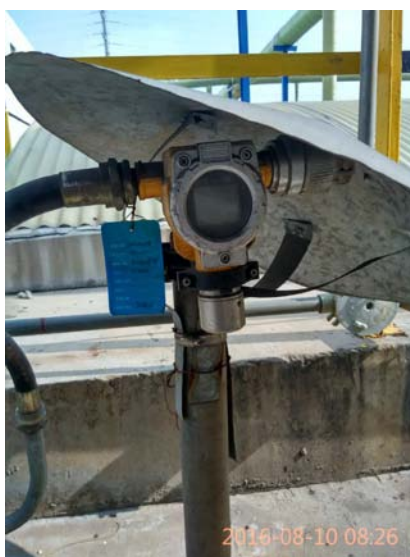
图 6-1c 调节池硫化氢报警器
