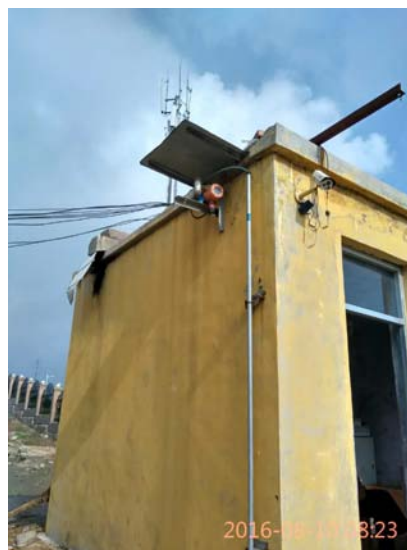
图 6-1d 门卫装硫化氢报警器
